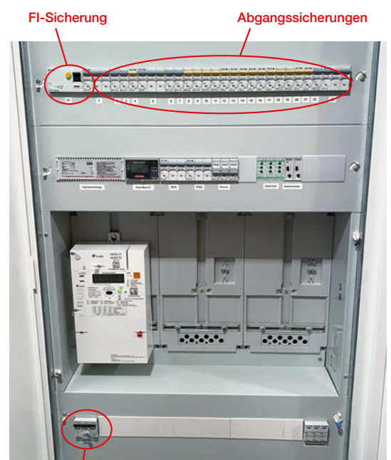
Vorzählersicherung / Tarifschalter
